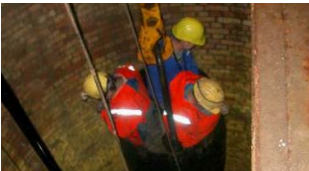
Kontrollbefahrung der Schachtröhre mit dem Kübel
