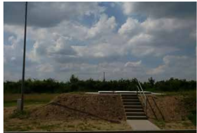
Blick auf die Biogaseinspeiseanlage Güstrow mit Flüssiggastank
